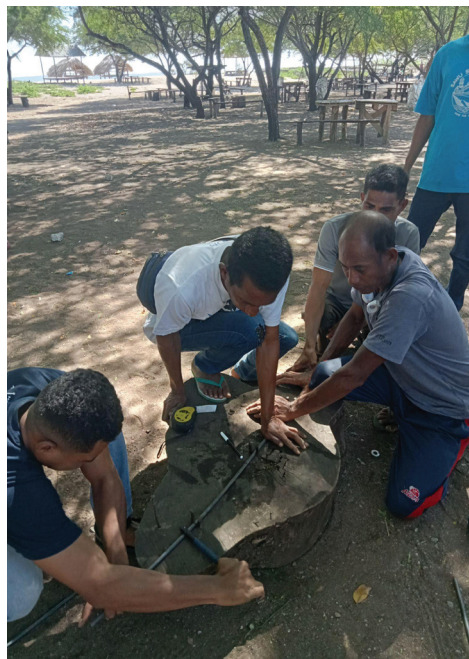
Gambar 9. Proses pembengkokan rangka besi utama (Sumber: YAPEKA)
